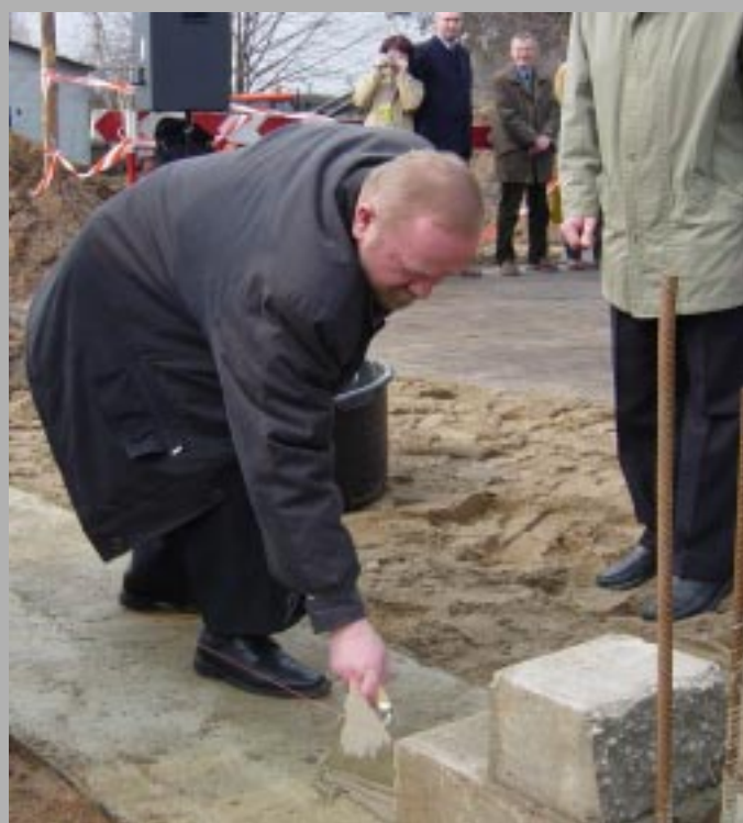
Burmistrz J. CZEKAŁSKI wmurował pierwszą cegłę pod budowę nowej kotłowni.
